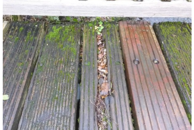
02 VERMODERTER BOHLENBELAG
