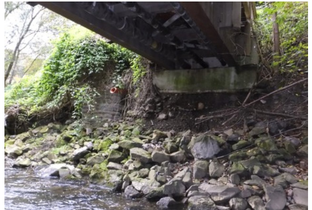
19 AUSGESPÜLTE BÖSCHUNG RECHTS
