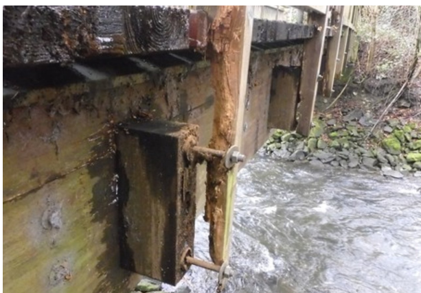
11 INSEKTENBEFALL AN GELÄNDERPFOSTEN
