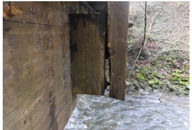
20 VERFAULTER GELÄNDERPFOSTEN
