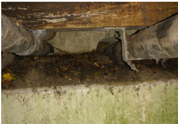
18 VERSCHMUTZTE AUFLAGERBÄNKE
