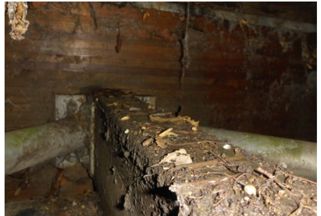
15 VERSCHMUTZTE QT-OBERSEITE
