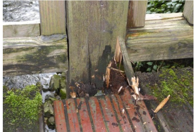
08 VERFAULTER GELÄNDERPFOSTEN
