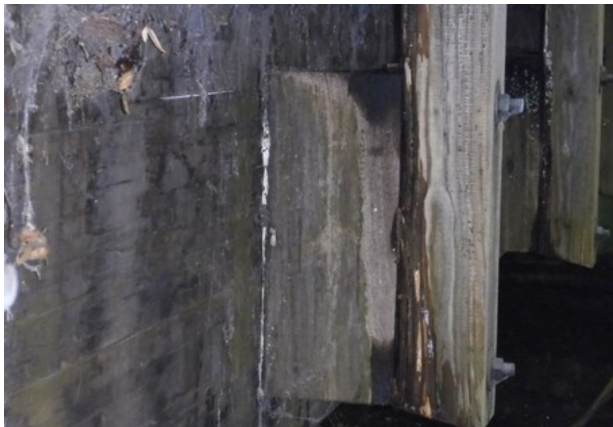
14 ANGEMODERTER PFOSTENANSCHLUSS
