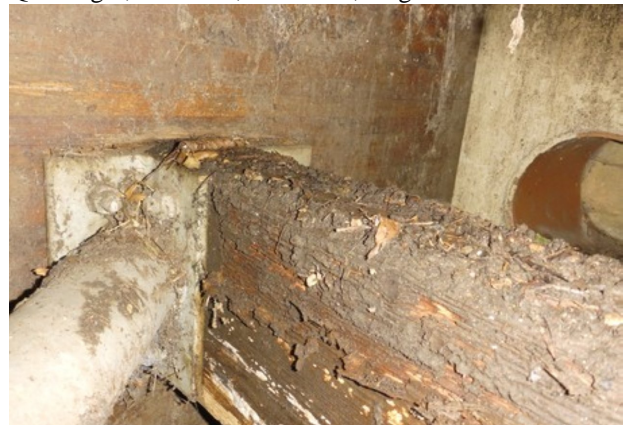
17 ANGEFAULTER QUERTRÄGER
