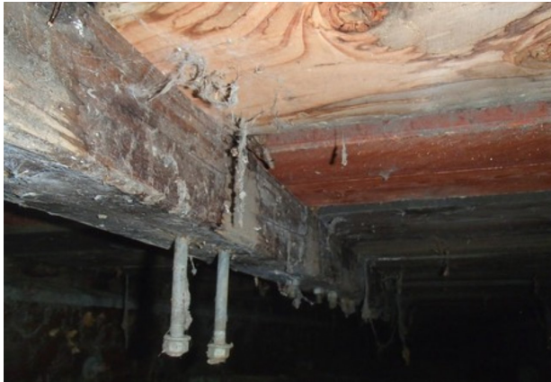
18 FEHLENDER KONSTRUKTIVER HOLZSCHUTZ AM MITTELHOLZ
